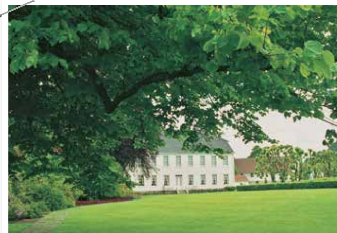
2011 BOEN GÅRD. HOVEDBYGNINGEN FRA 1813 ER RESTAURERT OG FØRT TILBAKE TIL OPPRINNELIG TILSTAND.
